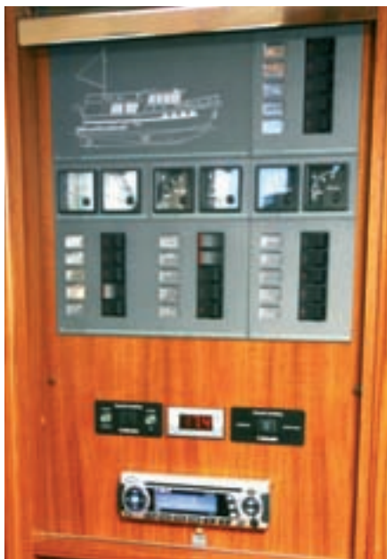
Elektrik vom Feinsten.
